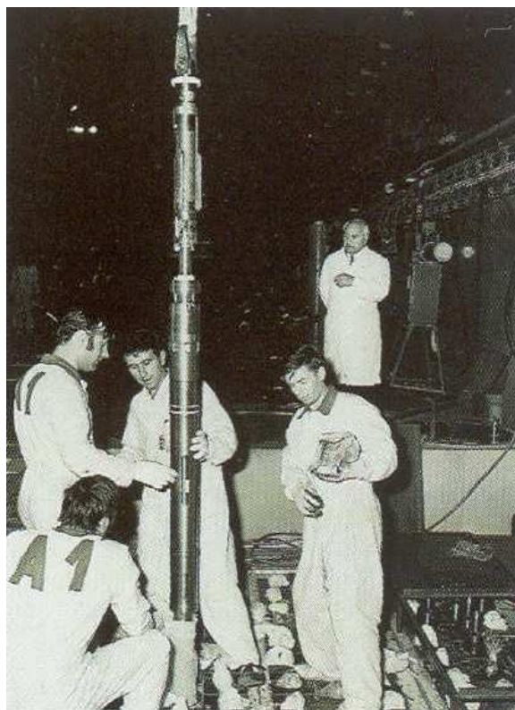
Obrázok 6. Zavážanie palivového článku do reaktora KS-150 [5].
