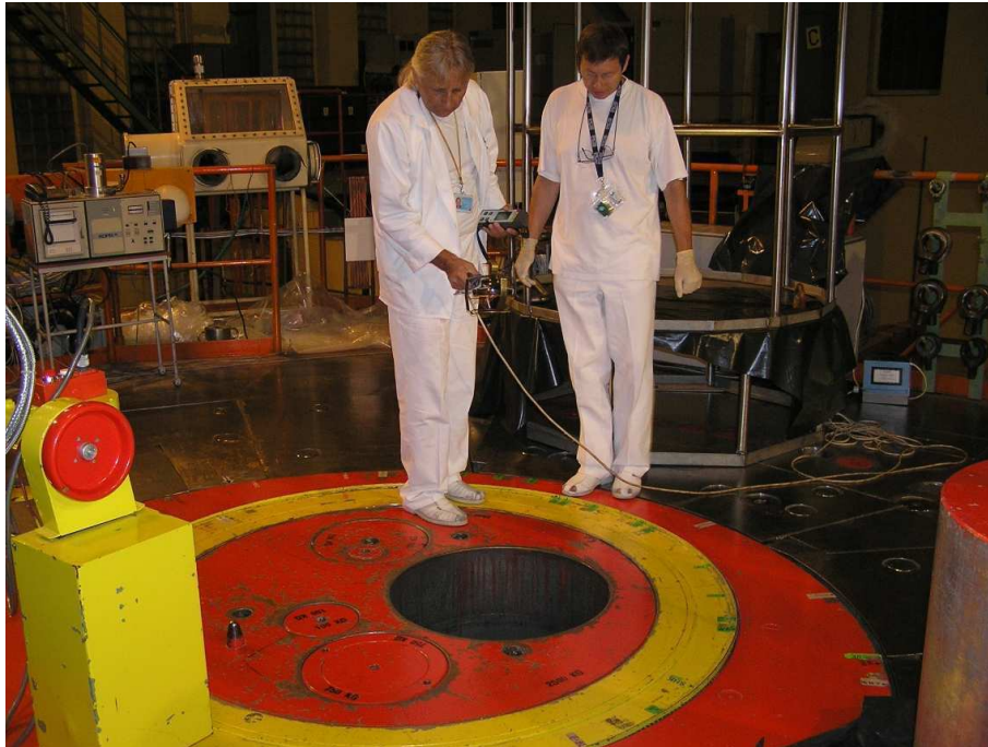
Obrázek 1. Víko reaktoru.
